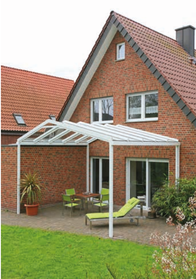
Giebeldach mit integrierter Rinne
